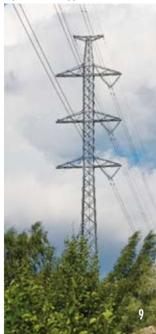
Harustamaton yksijalkainen vapaasti seisova pylvä
